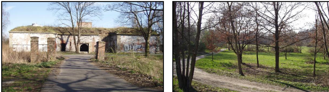
Obrázek č. 10: Pohled na Pivovarskou flošnu a přístupovou cestu k flošně
