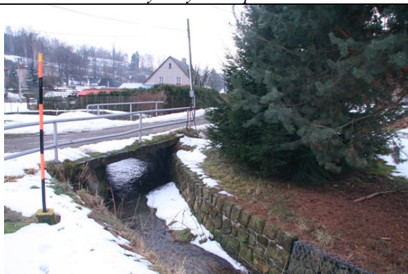
Křížení stoky C s upravenou částí toku v gabionech
