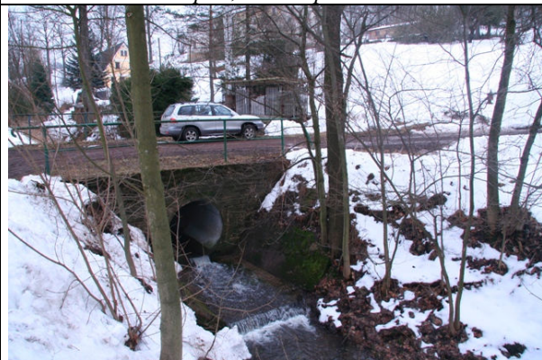
Prostor křížení stoky E3 ke statku, nutno podejít pod opevněním
