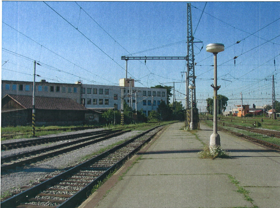
Obr.č.1 Pohled v km 27,6, v místě 1. prodlouženého nástupiště.
