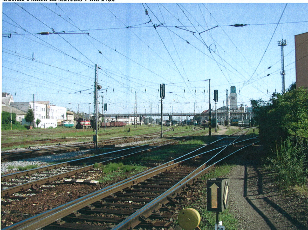
Obr.č.4 Pohled na jižní zhlaví z mostu v km 27,5.
