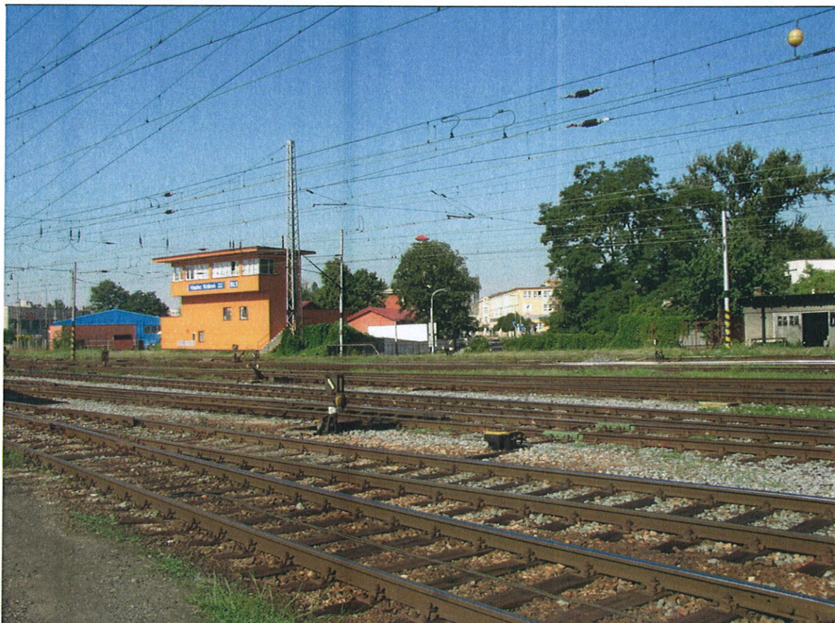
Obr.č.3 Pohled na stavědlo v km 27,6.
