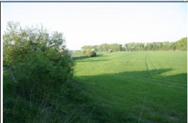
Pohled z hráze na pravobřežní část zátopy poldru, v levé části snímku polní cesta ve stopě řepařské dráhy
