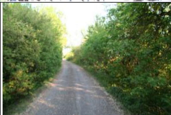
Charakter koruny hráze (náspu) v severní části
