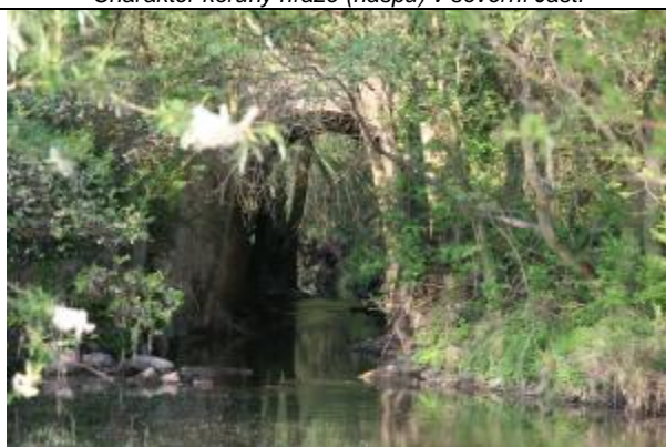
Klenbový mostek s tůní od podhrází, prostor vývaru
