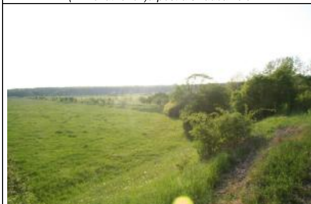
Dnešní stav výhledové vzdušné strany hráze poldru
