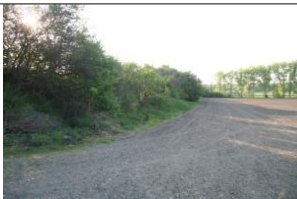
Pohled do jižní části návodní strany hráze, v tomto prostoru bude veškerý porost odstraněn
