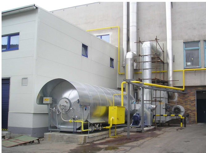
Obr. 4 – Termické spalovací zařízení WK TNV se systémem výměny tepla (4)
