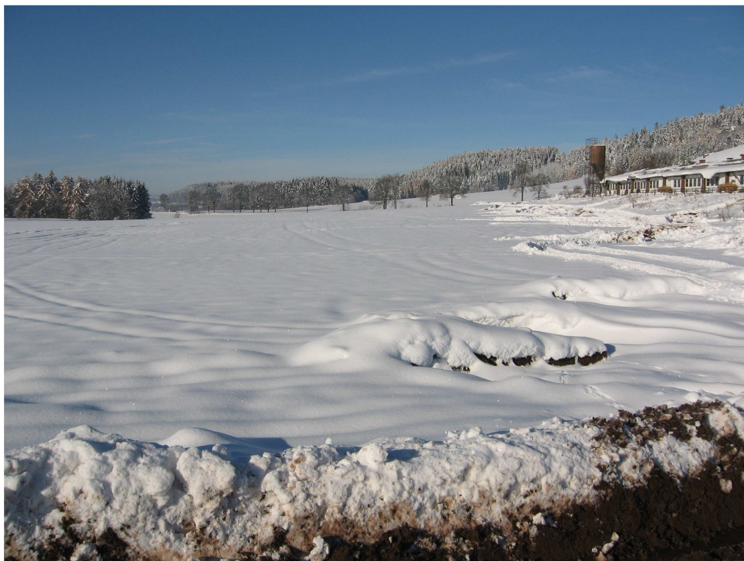
Pohled na místo výstavby stáje, dojírny, jímky a silážního žlabu.
