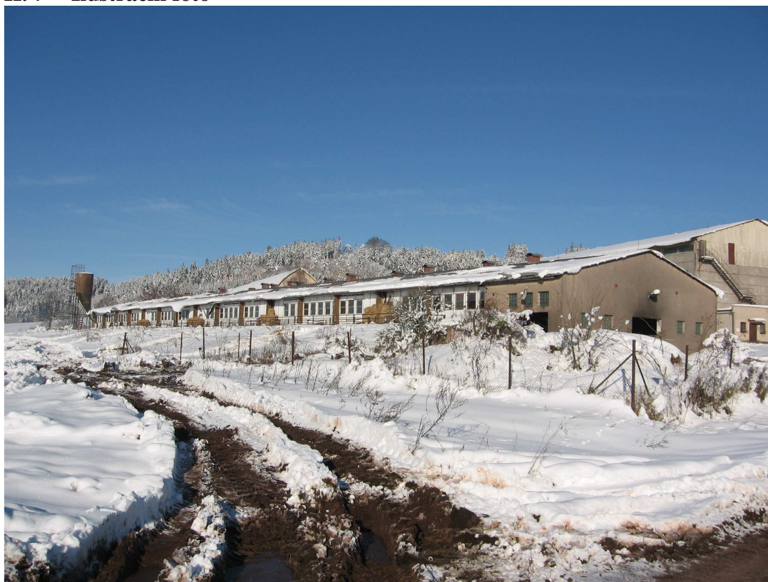
Pohled na stávající stáj BIOS
