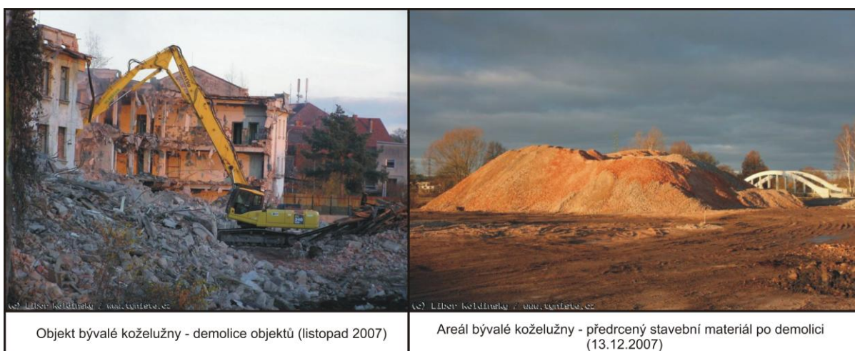
Obr. 7: Fotografie objektu koželužny z období demoličních a sanačních prací (zdroj: www.tyniste.cz, publikováno se svolením autora)
