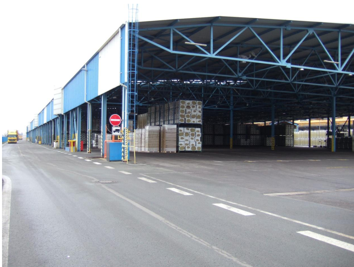
Stávající zastřešené sklady produktů v areálu
