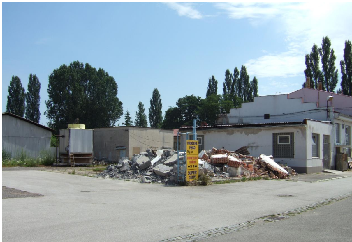
Obrázek 15 : Pohled na místo stavby – všechny objekty jsou určeny k demolici s výjimkou vyšší růžové budovy vpravo
