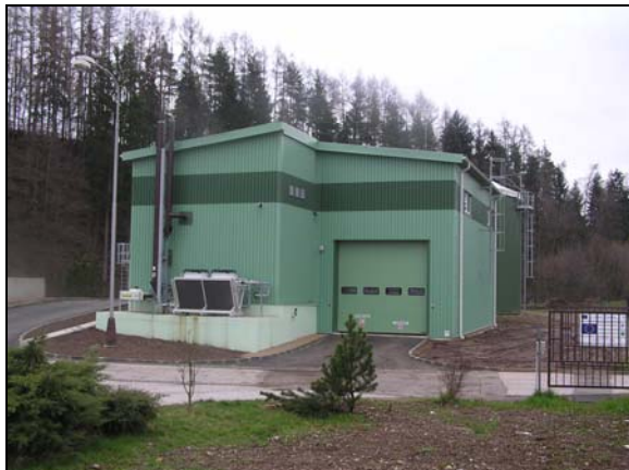
Areál BPS Úpice – stávající provozní a příjmový objekt
