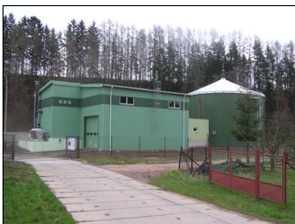
Příjezd do areálu BPS Úpice, provozní a příjmový objekt a fermentor
