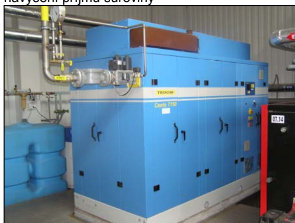
Kogenerační jednotka TEDOM v provozní budově BPS
