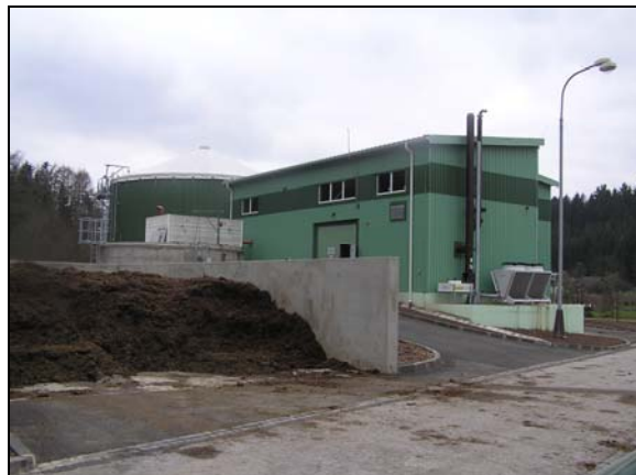
BPS Úpice, vlevo zpevněná plocha, na níž se předpokládá osazení zařízení Optimalizace a navýšení příjmu suroviny
