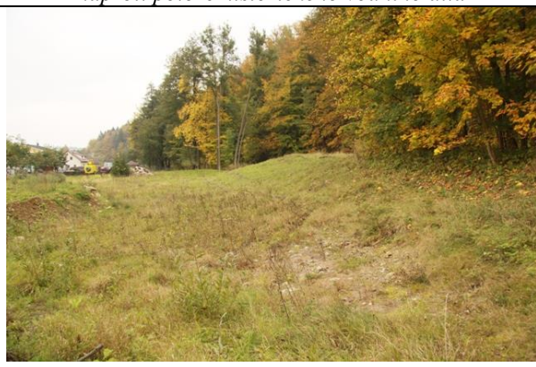
Průhled osou rybího přechodu (po proudu)
