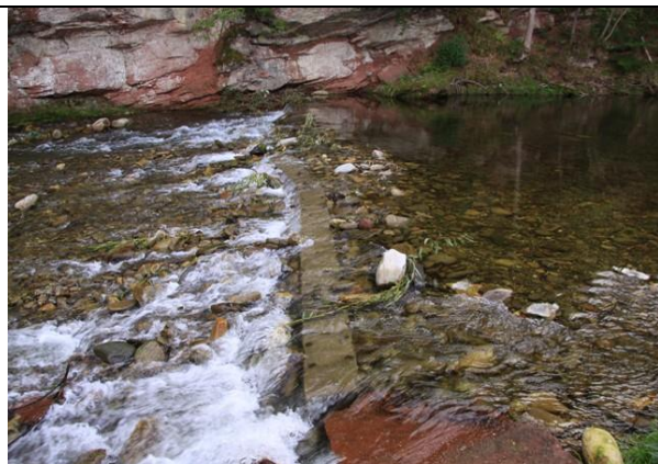
Pohled na zbytek původní jezové konstrukce
