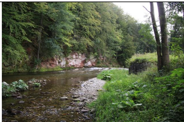
Profil jezu proti toku, vpravo zbytky opěrných zdí pův. VD a přerostlá štěrková lavice
