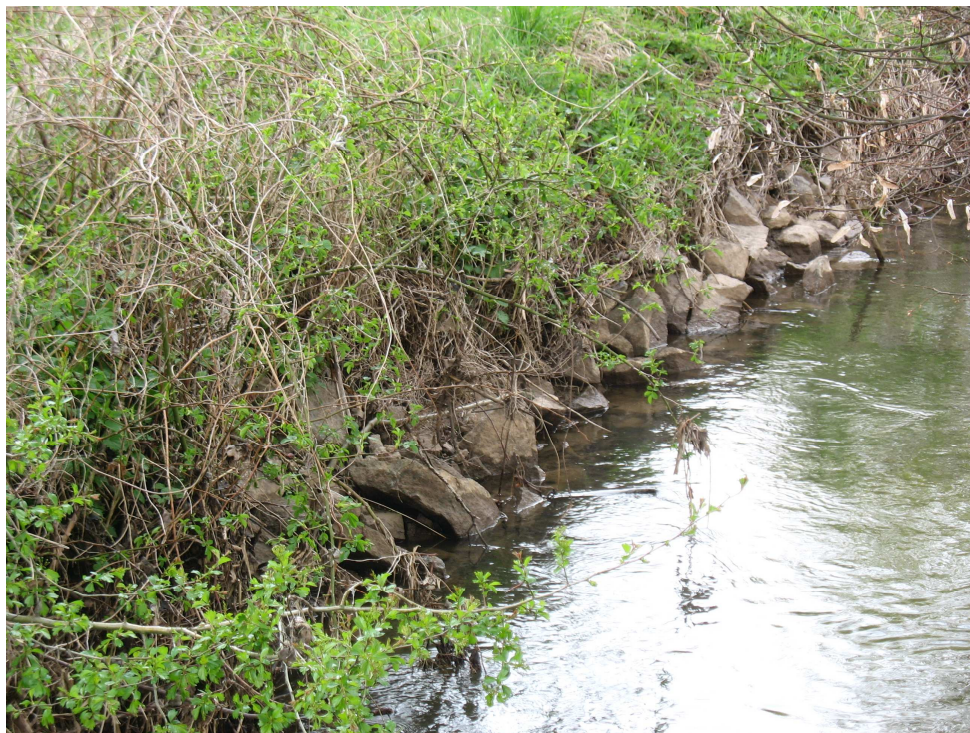
Obrázek 5: Pravý břeh Bystřice v místě vyústění odpadního potrubí z Bystřického rybníka
