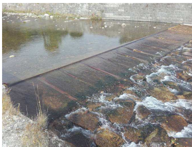
Obr. 2: Detail betonové přelivné plochy (situace 12.10.2015)
