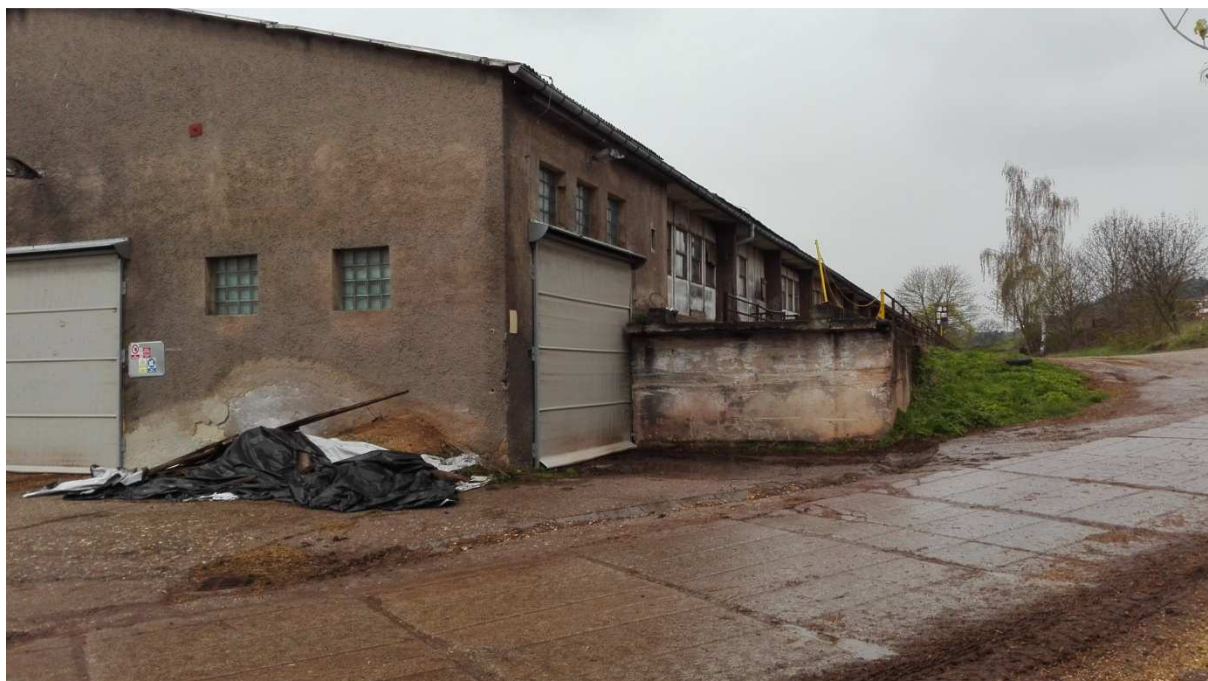
Stávající stáj určená k demolici
