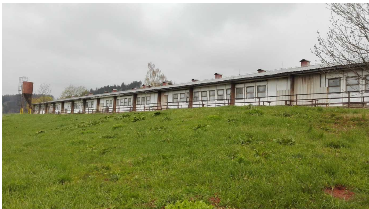
Stávající stáj určená k demolici
