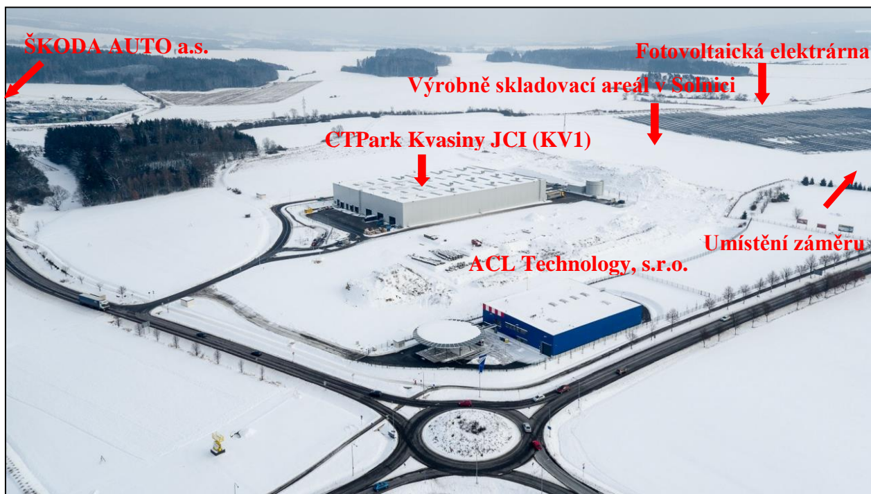
Obrázek č. 3: Pohled na objekt ACL Technology, s.r.o. a dokončenou halu KV1 (nyní JCI) společnosti CTPark Kvasiny, v pozadí vpravo fotovoltaická elektrárna
