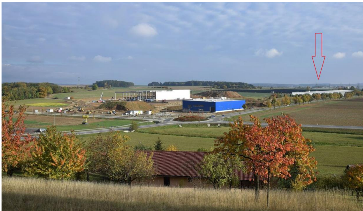
F.1.2 Umístění záměru Skladové haly Solnice; pohled z jižního okraje města Solnice, v popředí záměr ACL hala (modrý objekt), CTPark - hala JCI (bílý objekt); (Marek J. 2017)
