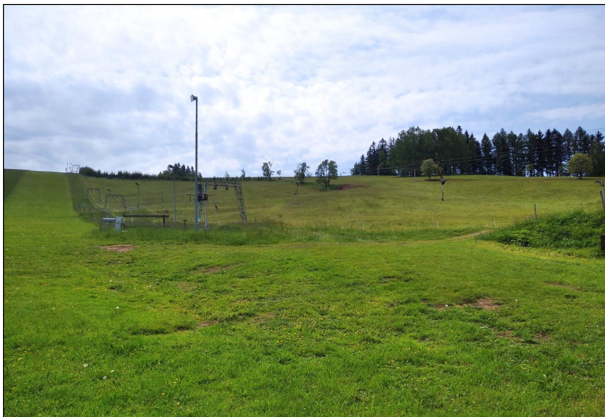
Obr. 7: Neexistující prameniště bezejmenného potoka (CEVT10168201) na ploše záboru stavby
