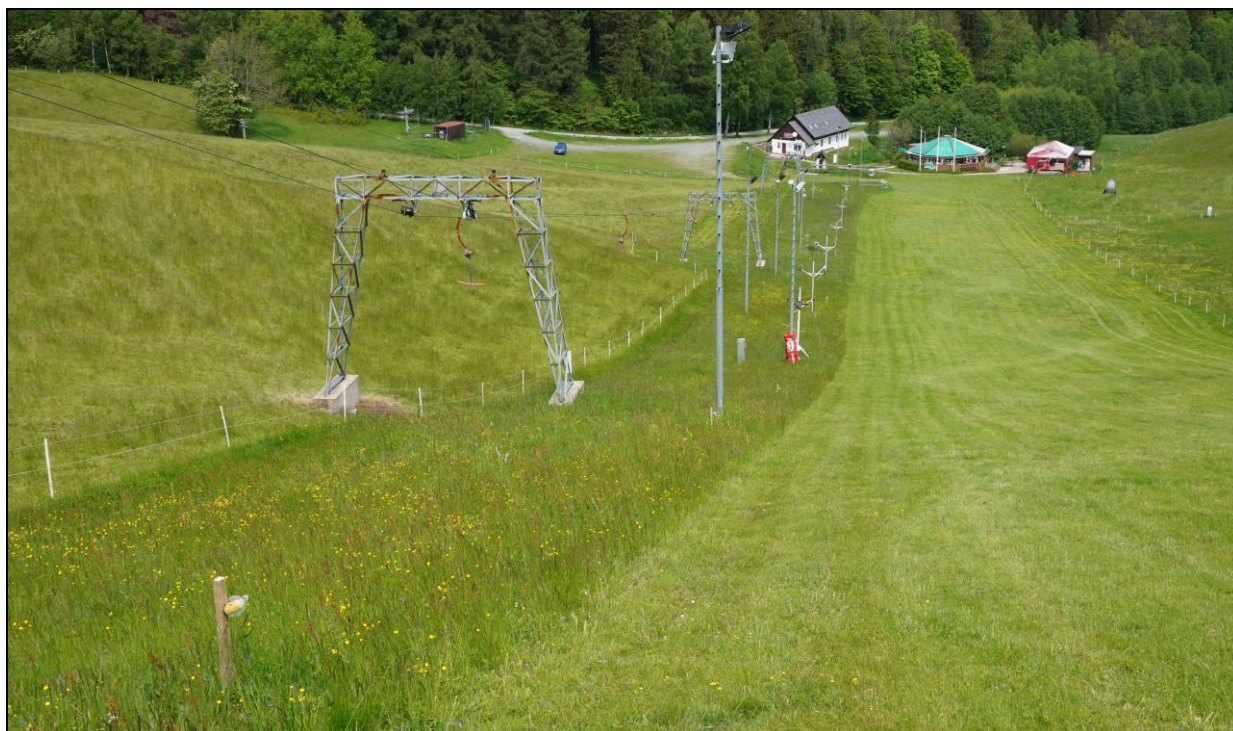
Obr. 1: Pohled na stávajícího traťové podpěry lyžařského vleku s dolní poháněcí stanicí a zázemím lyžařského areálu
