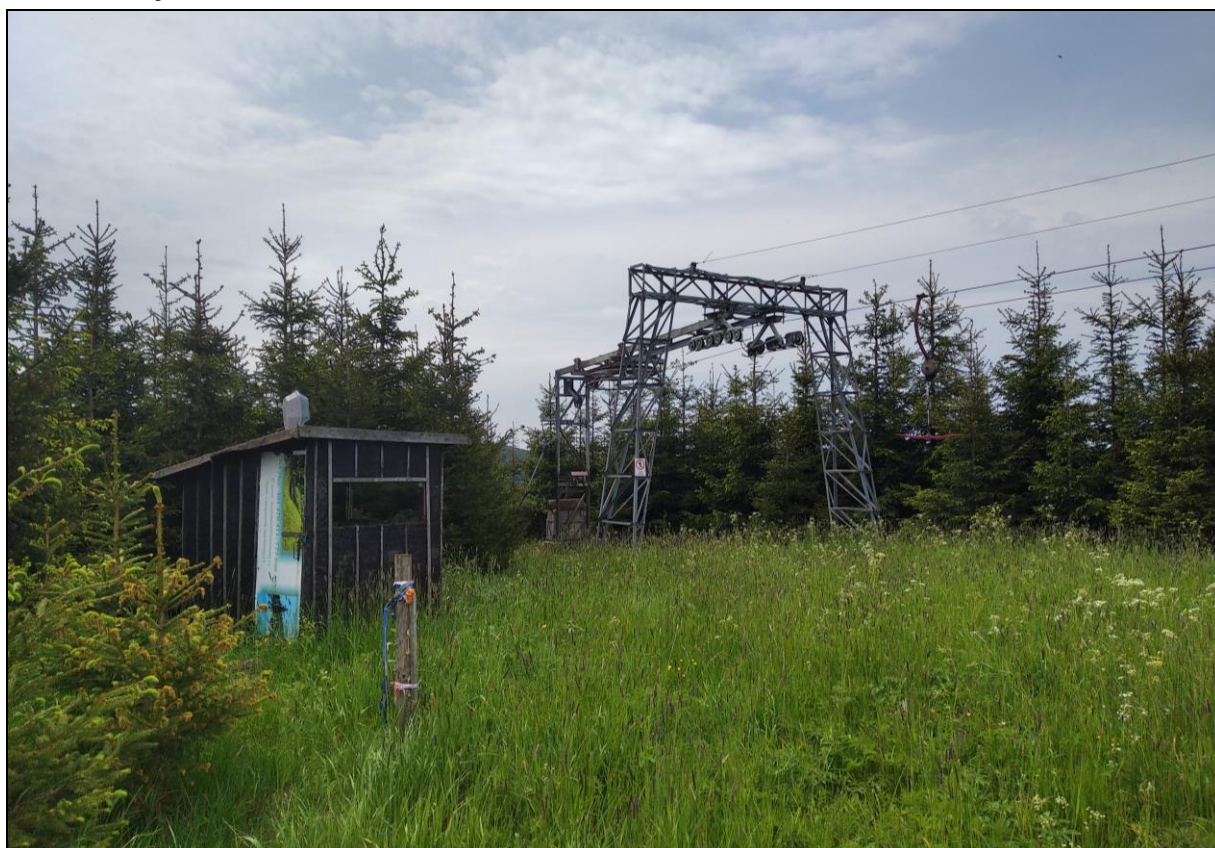
Obr. 2: Pohled na stávající horní napínací stanici lyžařského vleku a obslužnou budovu
