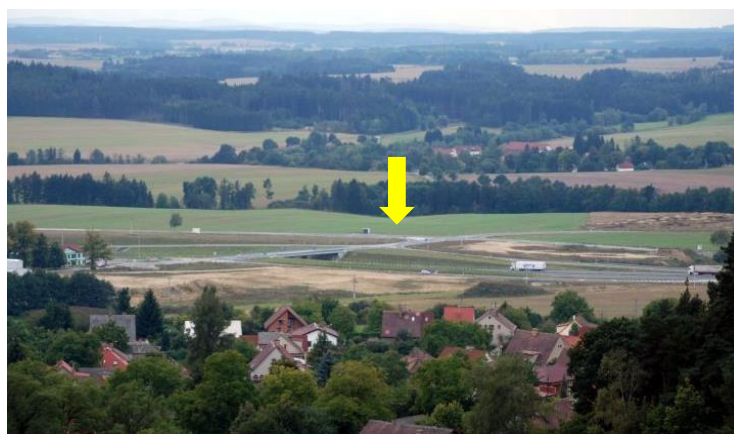
Obrázek 18 západní směr od obce Chotoviny pohled na dálnici a lokalitu pro budoucí areál
