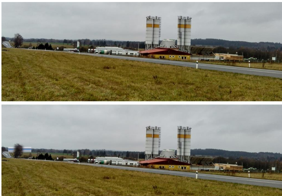
Obrázek 26 stavba hal na pozadí situovány do krajiny, v popředí místní betonárna, která více výškově prosazuje
