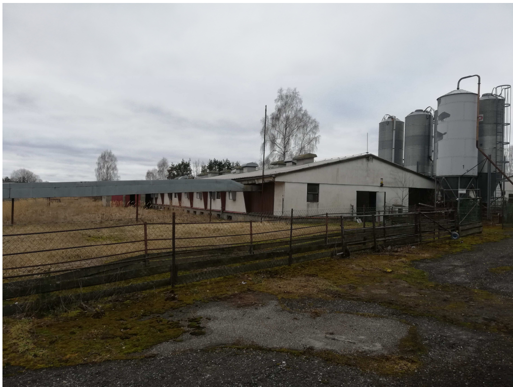
Stáj určená k demolici
