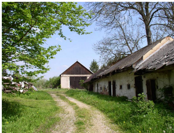
Budova D (v pozadí) a demolice
