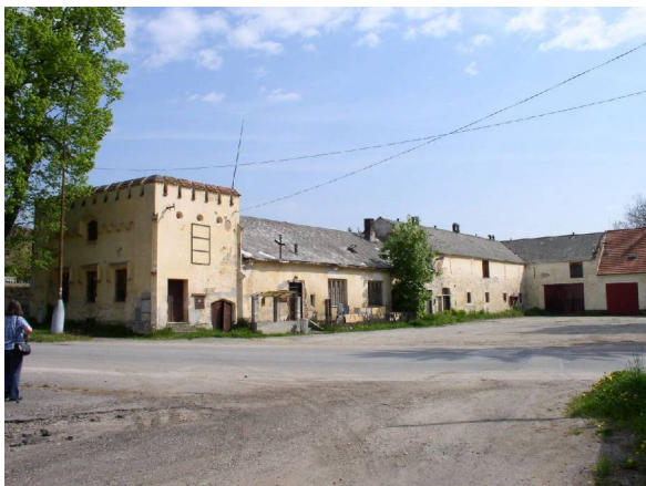
Budova C (vlevo) a demolice
