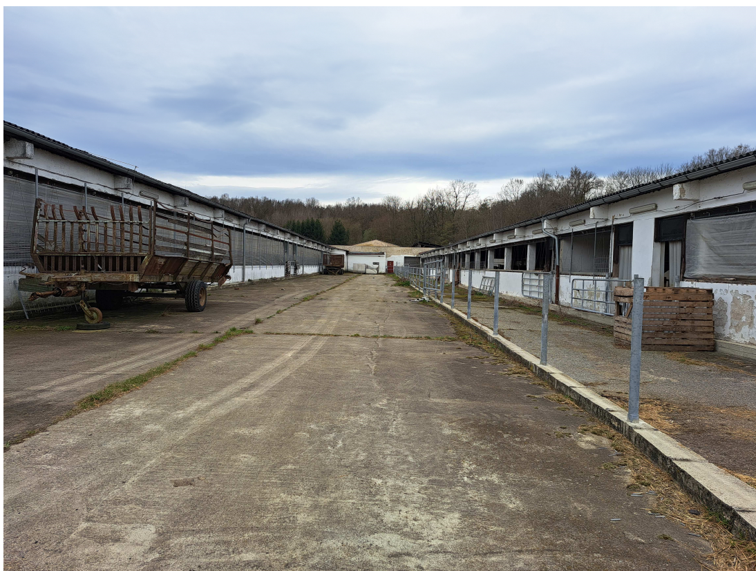
Pohled na prostor pro vestavbu centra robotického dojení
