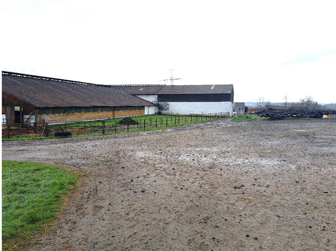
Pohled na prostor určený pro stavbu nové stáje
