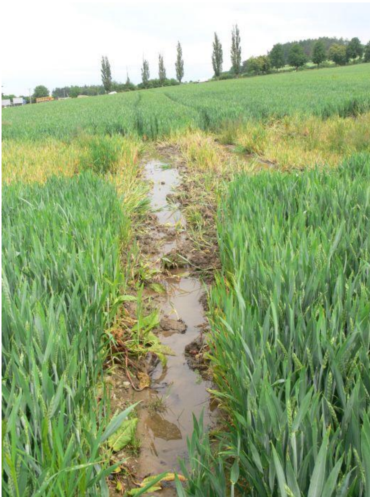
Úsek 5, prameniště v poli, střední část, pohled k silnici
