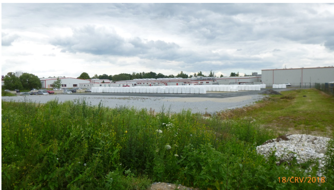
Obr.č. 26 : Pohled na území stavby od Jihu
