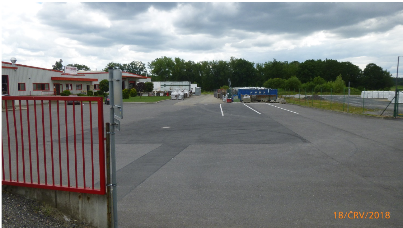
Obr.č. 27: Pohled na území stavby od haly V
