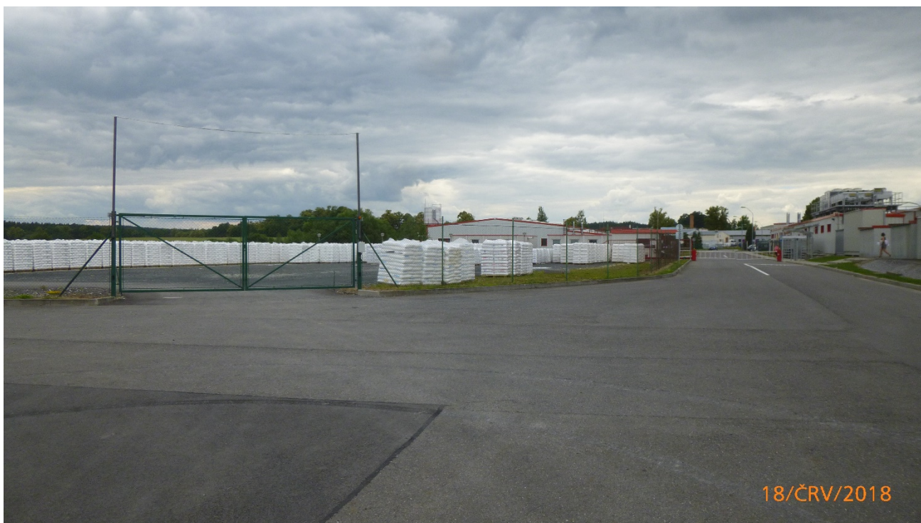
Obr.č. 28 : Pohled na území stavby od hal VIII a IX
