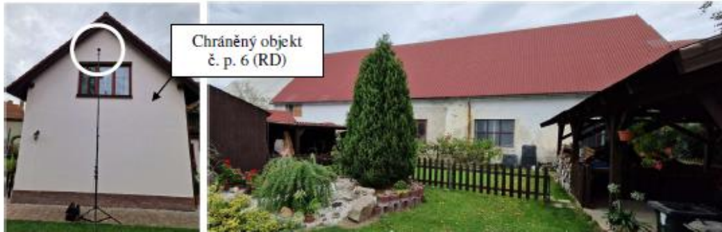
Obrázek 7: Pohled na MM3 (vlevo) a pohled z MM3 směrem k areálu předmětné provozovny (vpravo)
