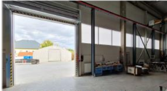
Obrázek 4: Pohled na zcela otevřená vrata v severozápadní fasádě objektu na parcele č. st. 1/1, 1/3 a 1/10 v době měření hluku
