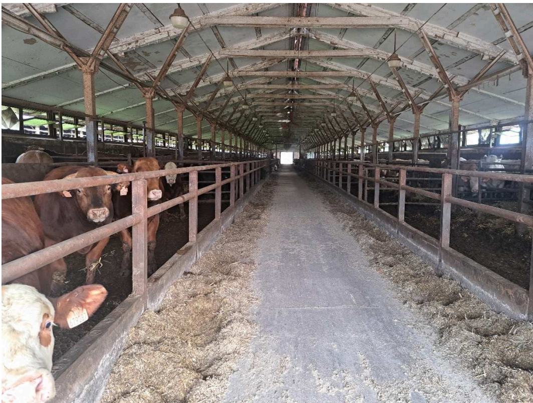
Pohled do stáje, která je určena k demolici
