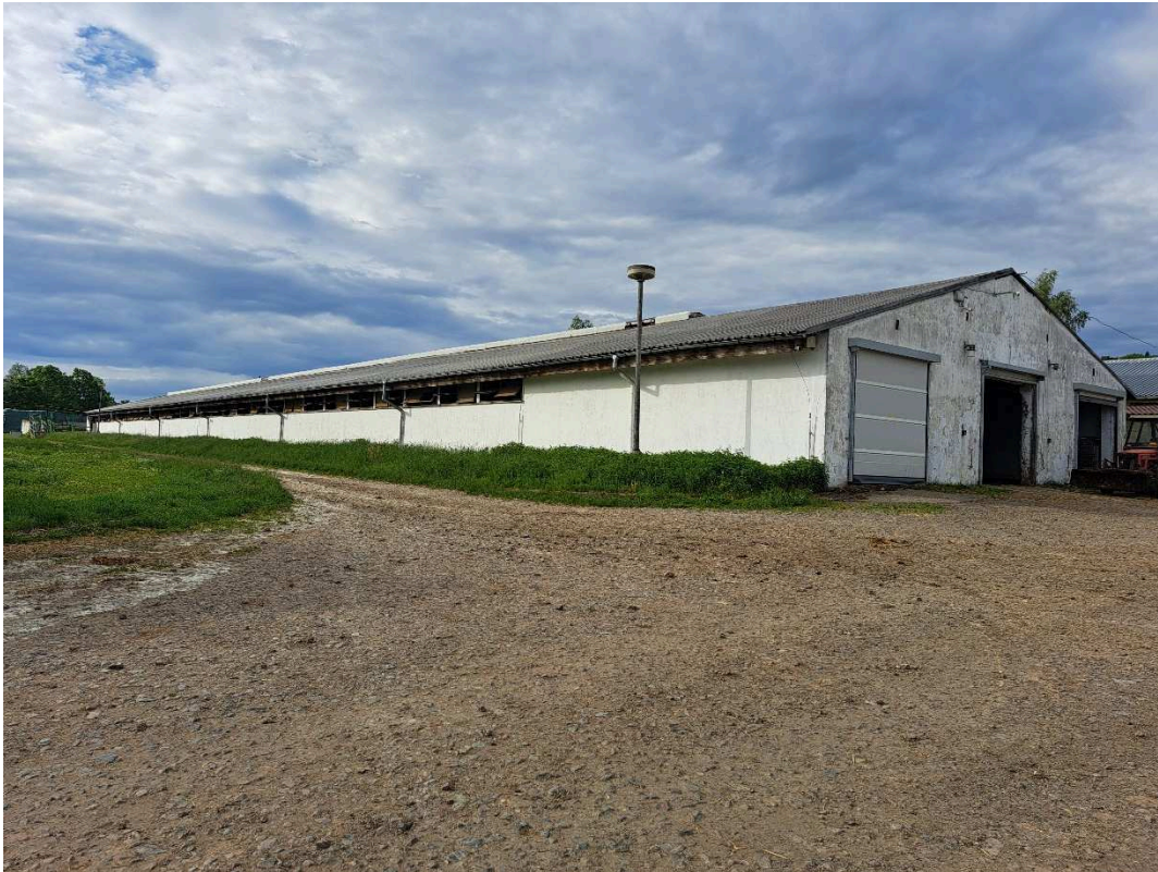
Pohled na stávající stáj určenou k demolici
