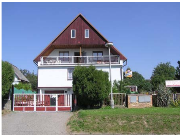
dům č.p. 252 v obci Tučapy
