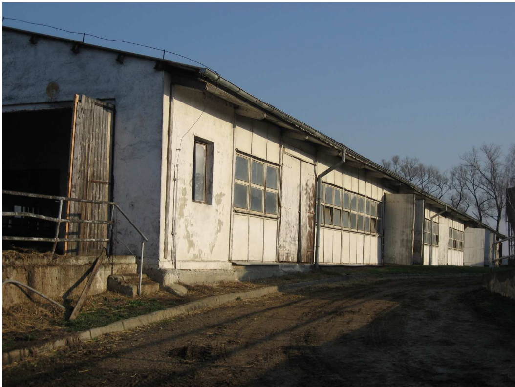
Pohled na místo stavby
