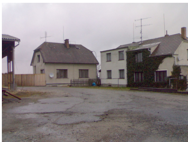
Obytné objekty v areálu pily
