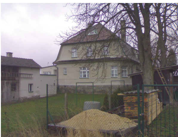
Obytný objekt u Nádraží Ševětín
