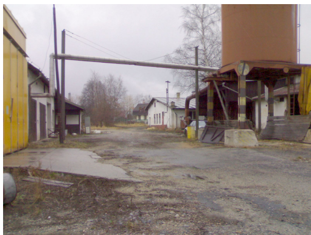
Areál býv. pily Ševětín, stávající stav
