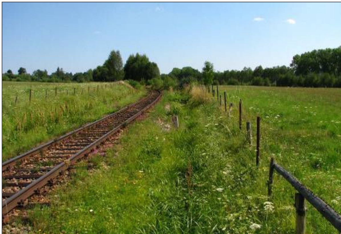
Obr 6. – Výskyt stanoviště 6510 ( Extenzivní sečené louky... ) v EVL Šumava nedaleko Horní Plané. Jedná se o porosty méně reprezentativní, ovlivněné intenzivním využíváním. Segment nebude záměrem negativně ovlivněn, pokládka kabelu bude probíhat na drážním pozemku.
