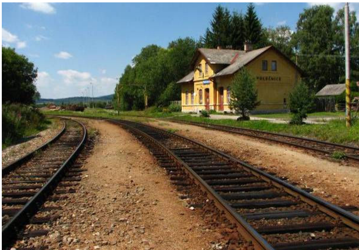
Obr 1. – ŽST Polečnice (EVL a PO Boletice). V tomto úseku trati budou probíhat kolejové úpravy (odsunutí koleje, budování nástupiště, odvodnění kolejiště) s cílem zvýšit návrhovou rychlost trati.
