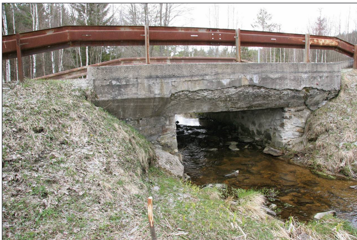
Obr. 1. – Stávající mostní konstrukce mostu ev. č. 165-005 u obce Zbytiny
