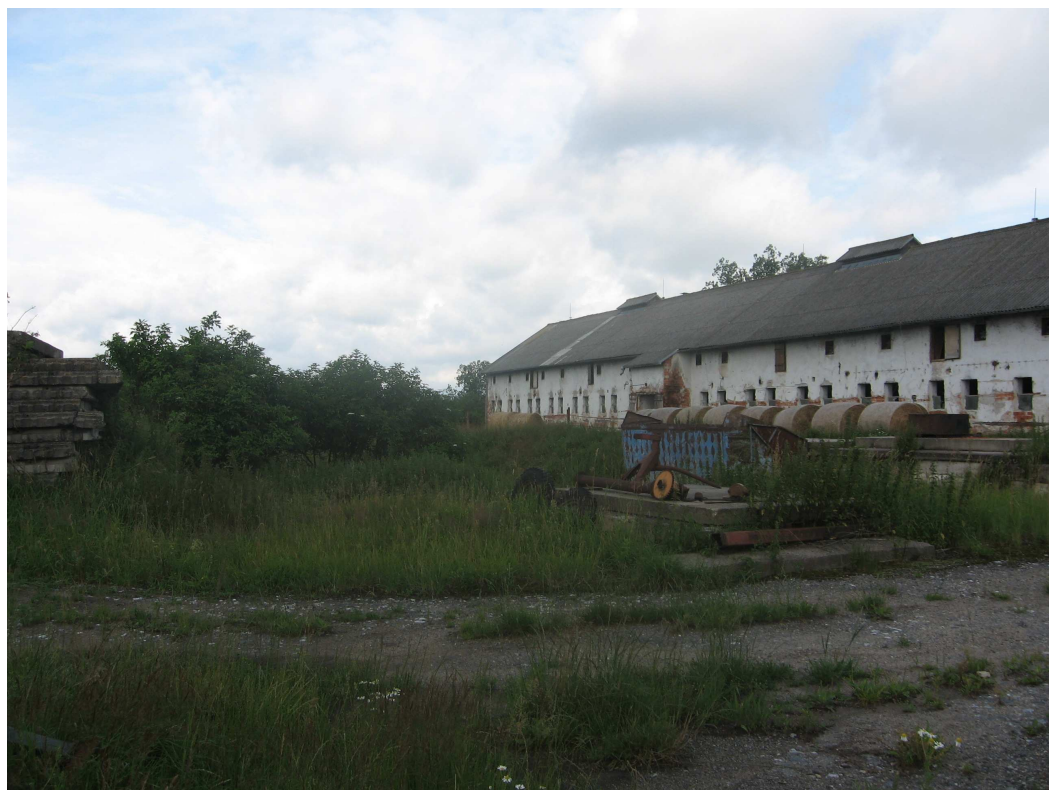
Pohled na místo výstavby a stáj určenou k rekonstrukci
