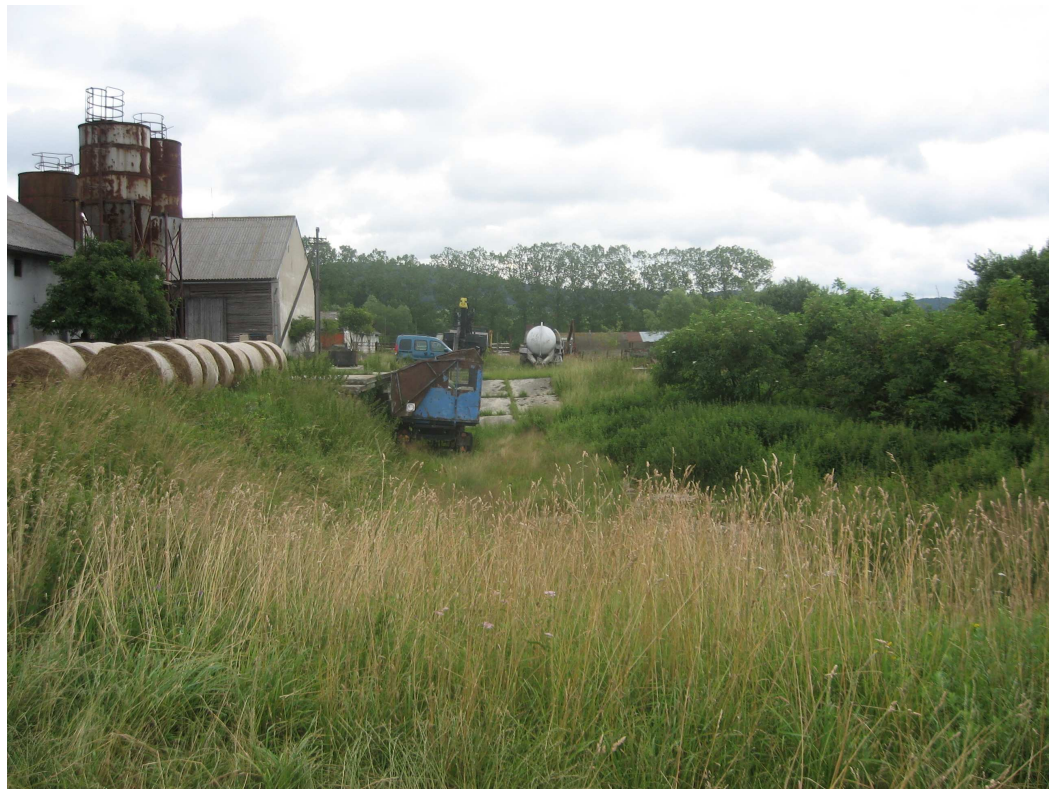
Pohled na místo výstavby nové stáje
