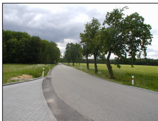
Komunikace III. třídy směrem na Ledenice; vjezd do areálu BEST, a.s.
