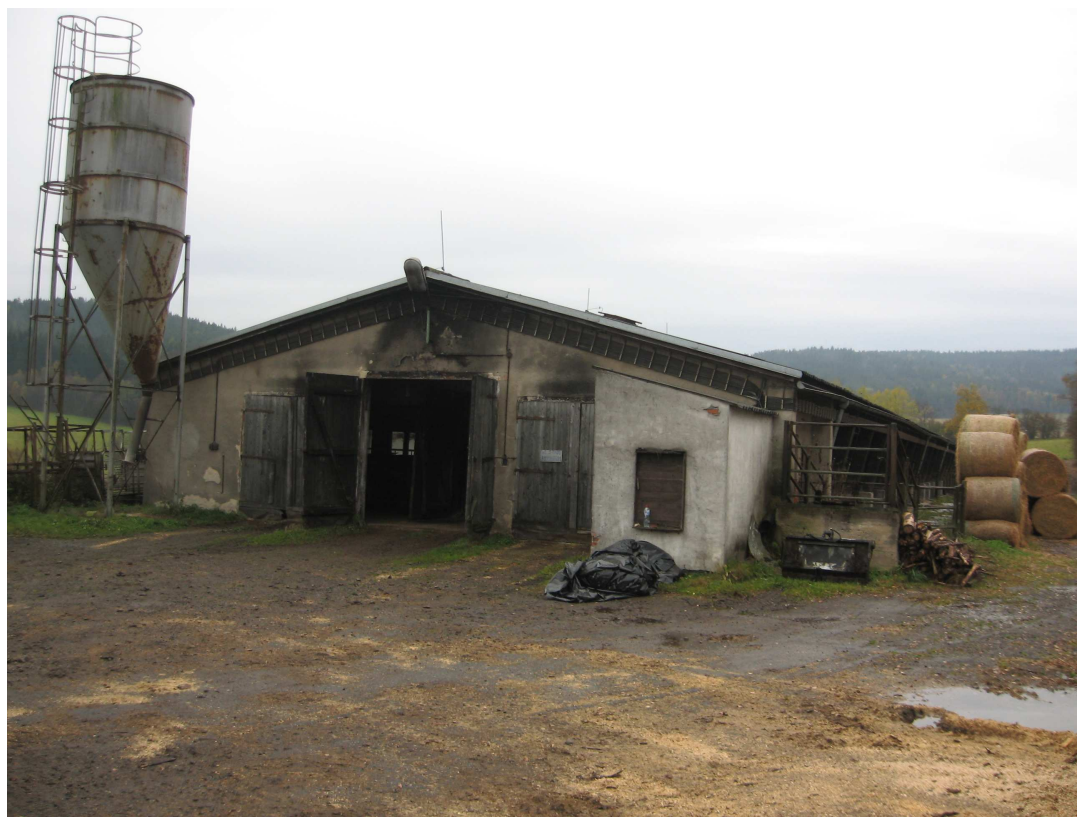
Pohled na stáj určenou k rekonstrukci a přístavbě
