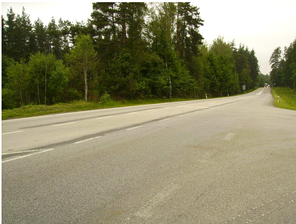
Obr. č.1: Současný sjezd z komunikace E55 na účelovou komunikaci k areálu. (Tento sjezd zůstane zachován i po realizaci záměru)
