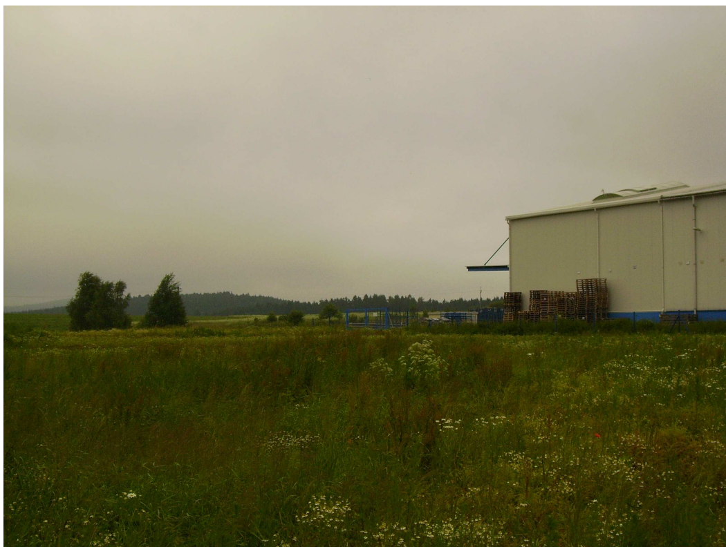
Severní pohled na část výrobní haly a charakter okolní krajiny
