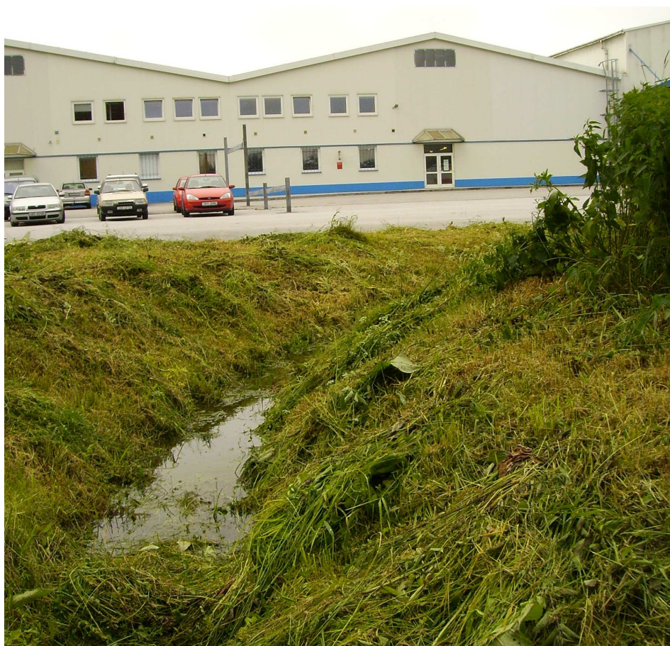
Pohled na vstupní část haly a odvodňovací stoku
