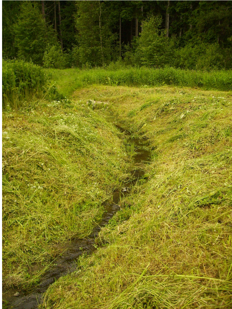
Obr. č.8: Současná stoka odvádějící dešťové vody z areálu do Novodomského potoka
