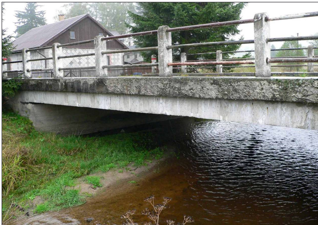
Obr. 3. – Stávající konstrukce mostu ev. č. 1652-2 přes Blanici. Foto - H. Brázda.
