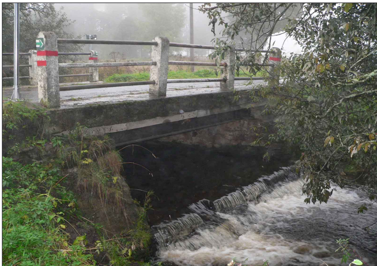
Obr. 2. – Stávající konstrukce mostu ev. č. 1652-1 přes Puchěřský potok. Foto - H. Brázda.
