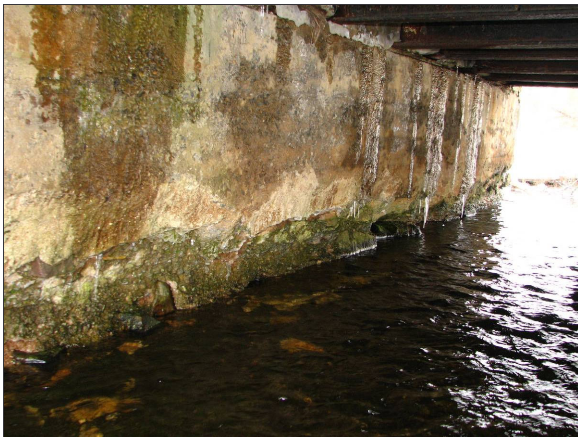
Současný stav spodní stavby mostu ev. č. 1652-1 přes Puchěřský potok. Foto - O. Bílek.
