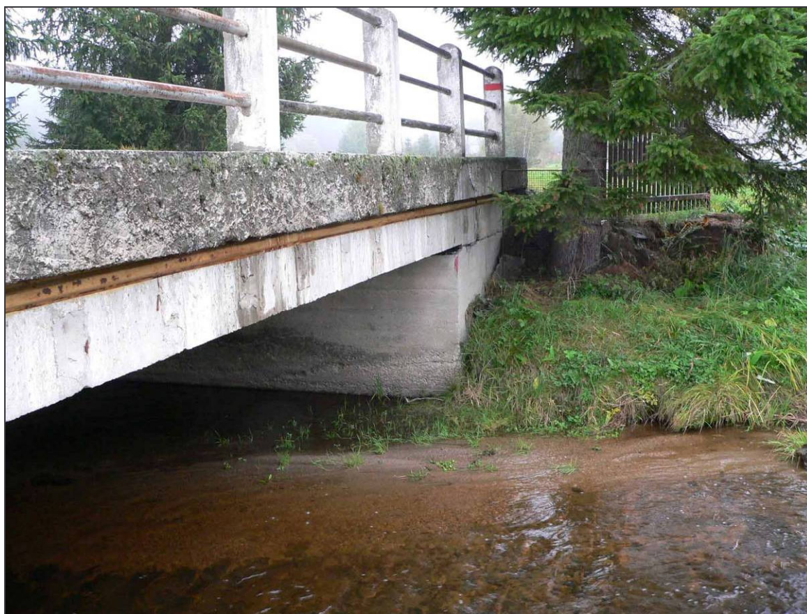
Stávající konstrukce mostu ev. č. 1652-2 přes Blanici. Foto - H. Brázda.
