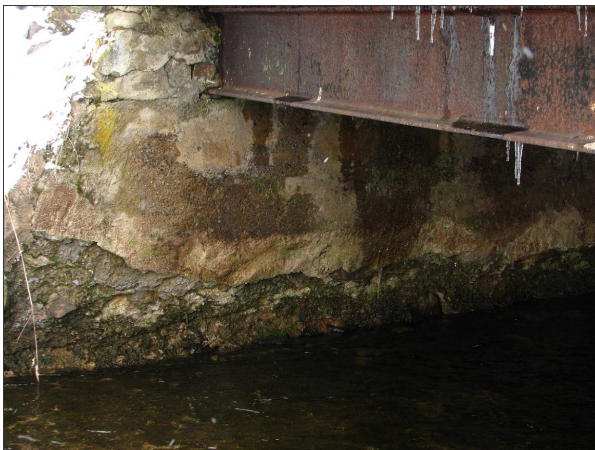
Detail levobřežní opěry mostu ev. č. 1652-1 přes Puchěřský potok. Foto - O. Bílek.
