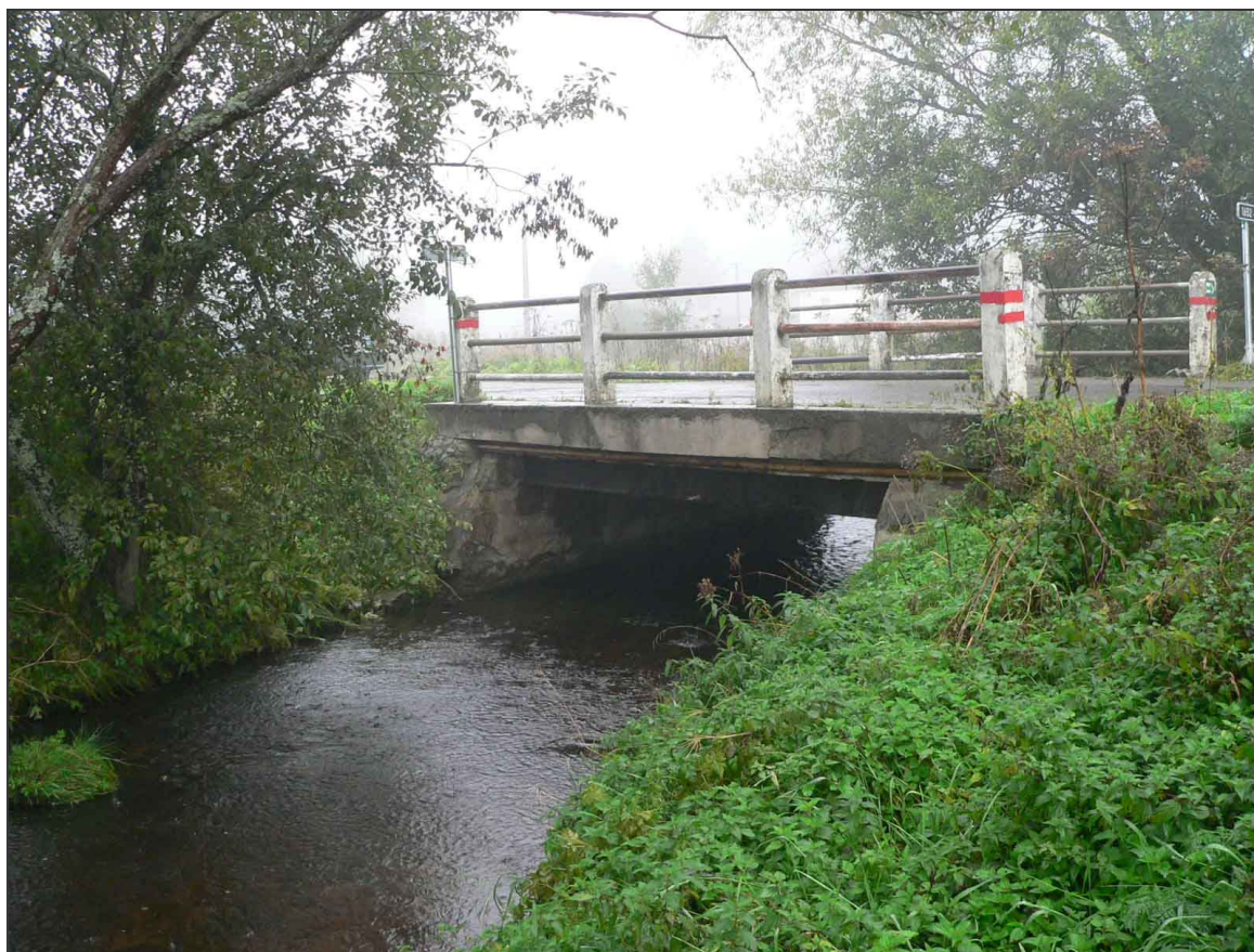
Stávající konstrukce mostu ev. č. 1652-1 přes Puchéřský potok. Foto - H. Brázda.
