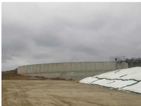
(Pohled na koncový sklad digestátu)
