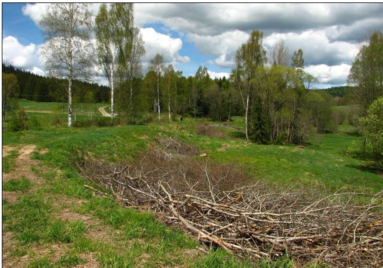
Foto 5. Prostor deponie č. 1 pod hrází – ponechané větve z pokácených dřevin zpevní uložený sediment.
