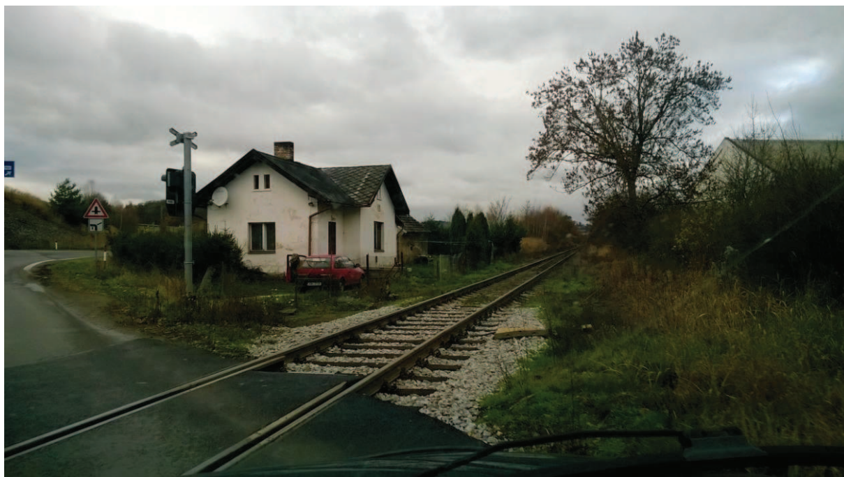
Foto 8: pohled na obytný dům ČD a přejezd na Dobešické ulici
