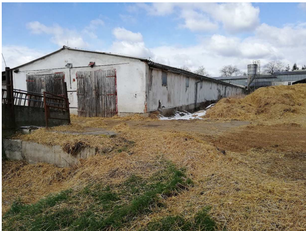
Pohled na stáj určenou k demolici
