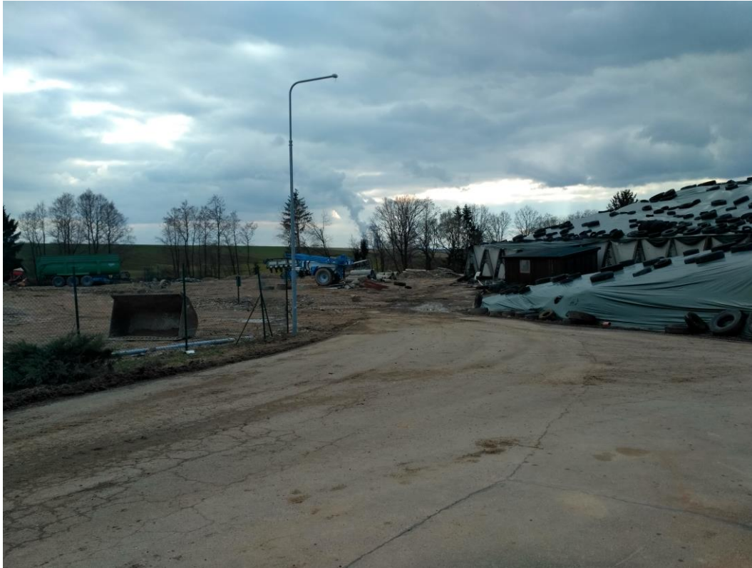
Prostor stavby haly u silážního žlabu
