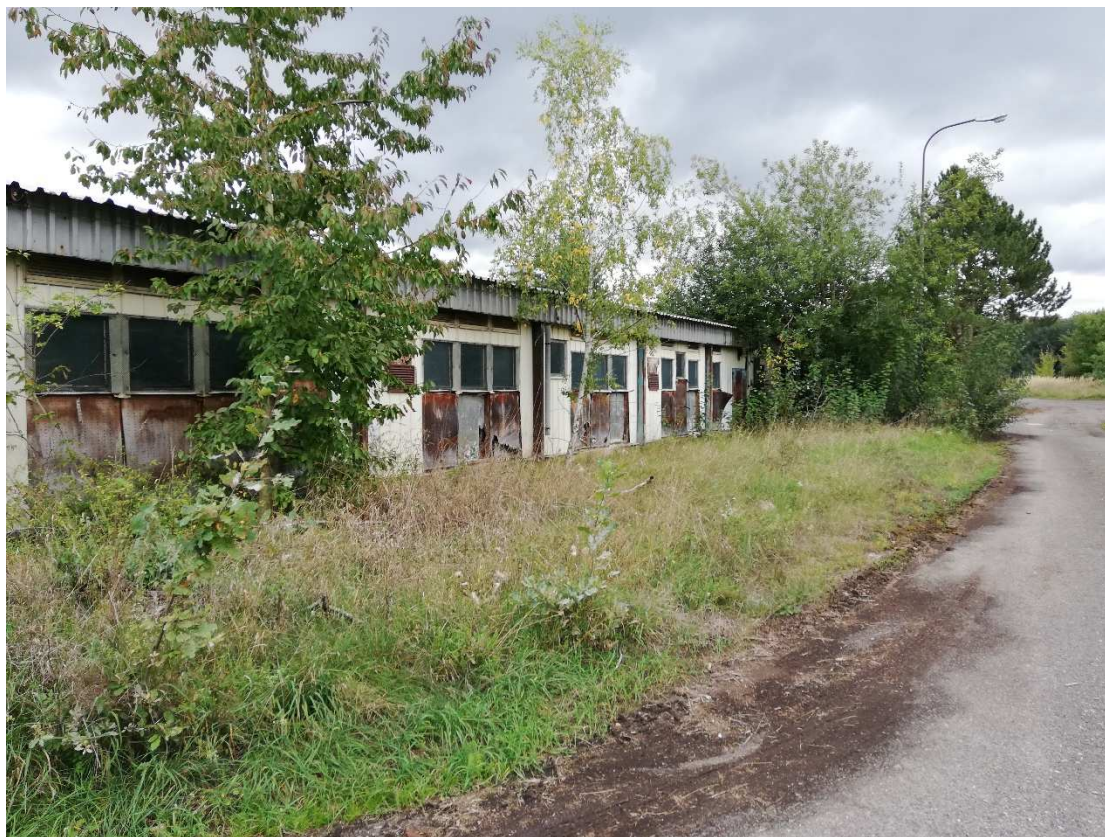
Pohled na stáj určenou k demolici
