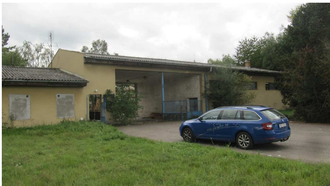
Pohled na vjezd do areálu určený k demolic
