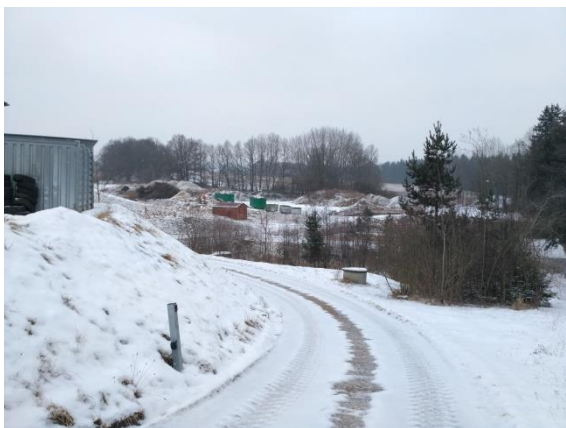
pohled na sběrný dvůr na stavební odpady a bioodpady
