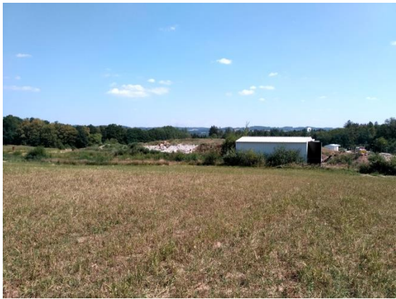
celkový pohled na skládku
