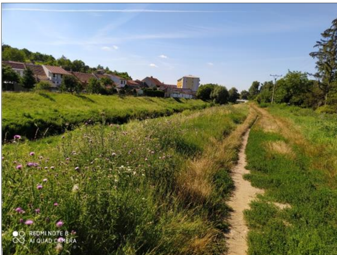
Foto č. 8: Obslužná komunikace podél východního okraje lokality
