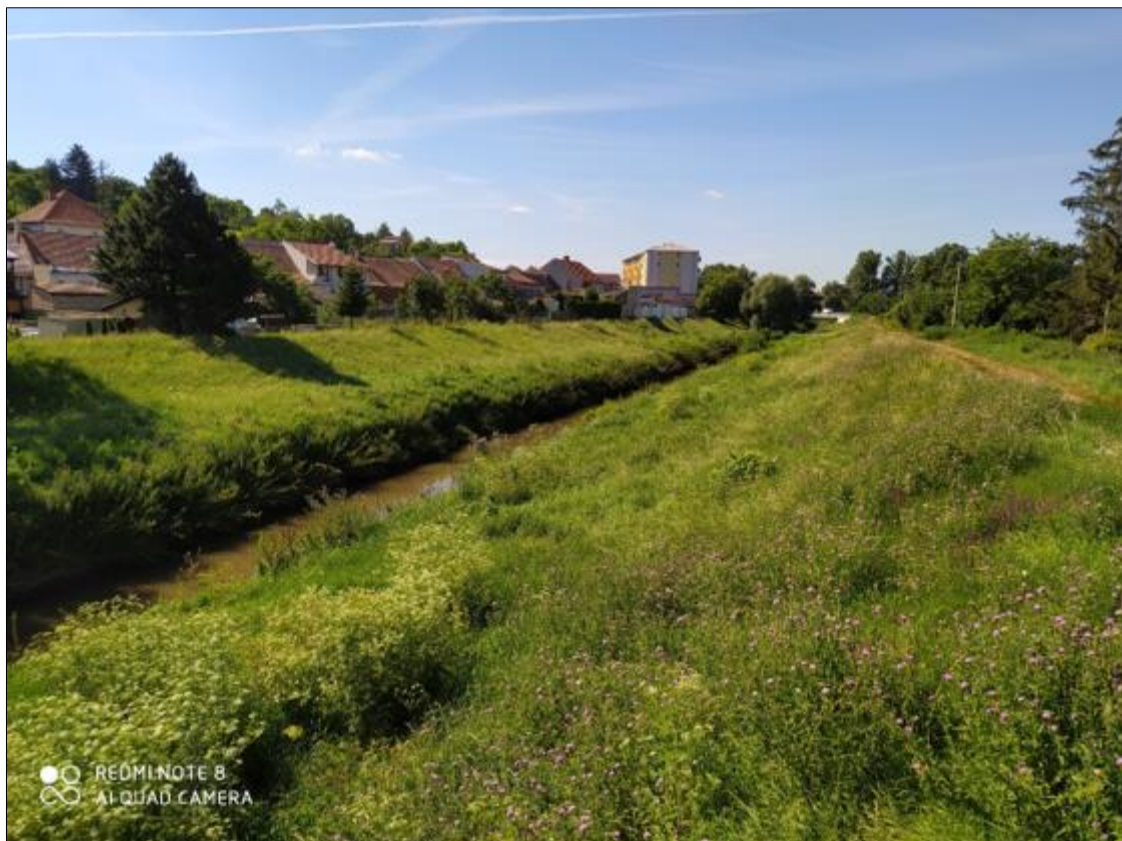
Foto č. 7: Regulované koryto řeky Litavy (Cézavy) podél východního okraje lokality
