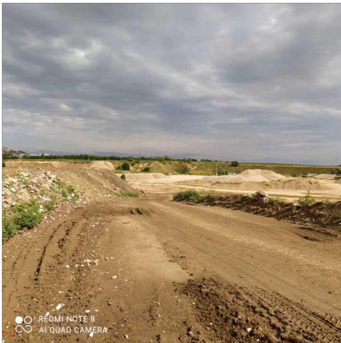
Foto č. 4: Pohled na prostor budoucí technické rekultivace
