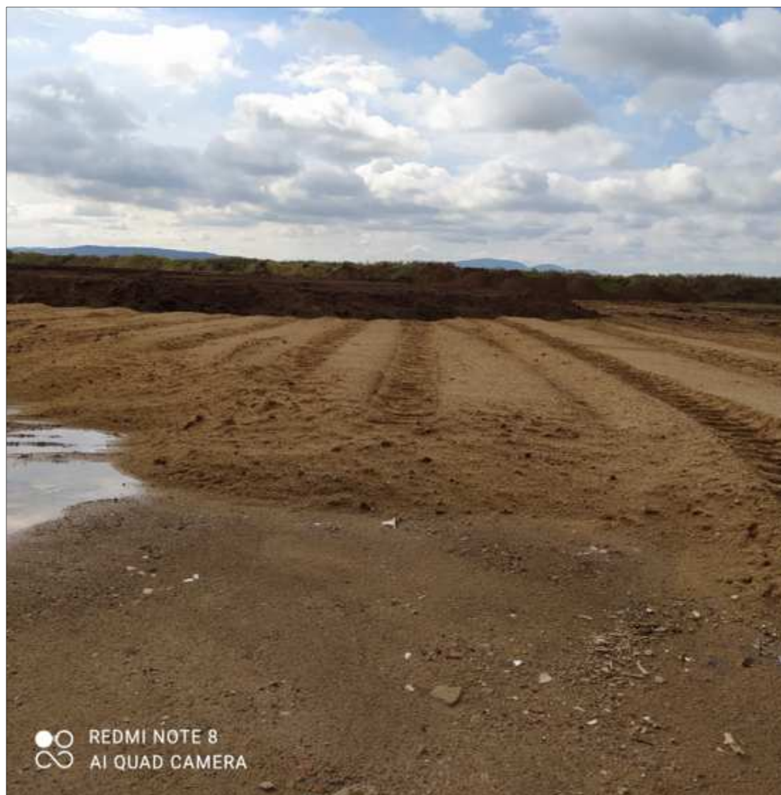
Foto č. 2: Navážení vrstev biologické rekultivace (v pozadí)
