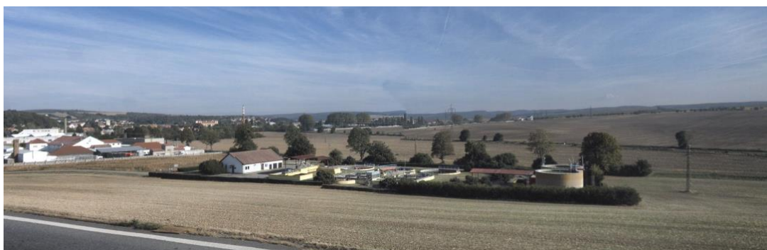
Obr.10 – celkový stav porostů u ČOV Bučovice (lze porovnat se stavem na obr.4)
