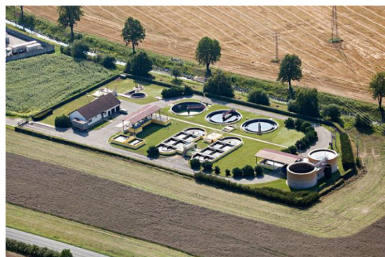
Obr.4 – celkový pohled na ČOV Bučovice v době počátku jejího provozu
