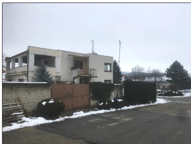
Obr. 6: Pohled na místo měření M2
