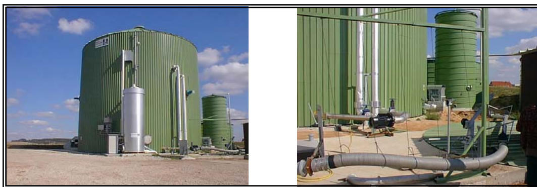
Bioreaktor s odsiřovací jednotkou a čerpáním bioplynu
