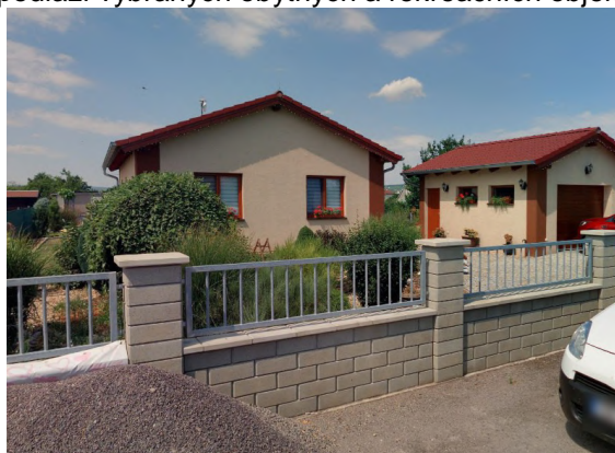
RB 1 – Oblekovice č.ev. 6160
