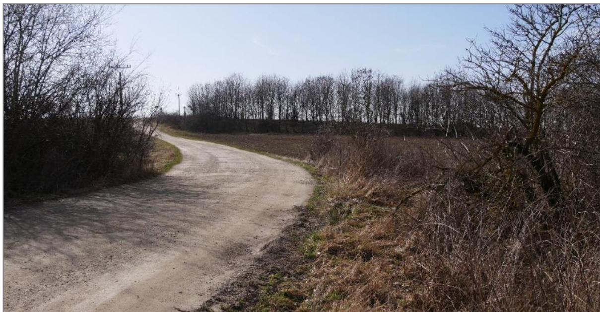
Pohled z jižního okraje LBC.4 Rybníček k místu budoucí křižovatky a odbočkou na Jamolice.
